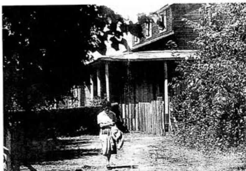
Antigua casa pastoral de Maquehue, posteriormente ampliada como hospital.
