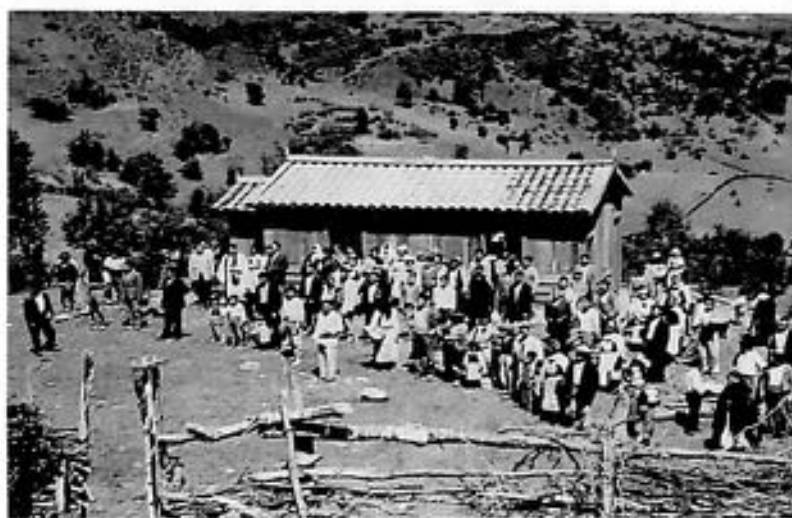
Iglesia de Pellahuén construida durante 1962
